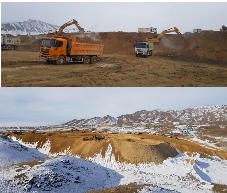
Процесс планировки поверхности ФБР (декабрь 2022 г.).
