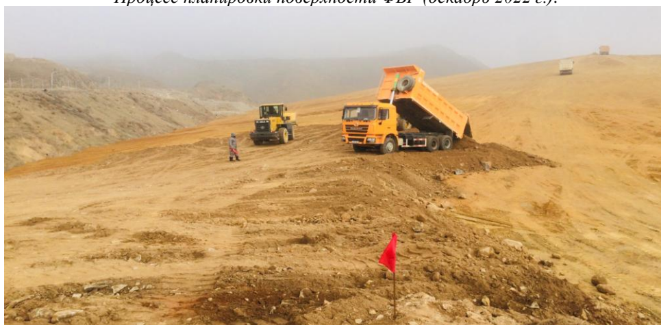
Процесс покрытия поверхности отходов ФБР нейтральным грунтом (январь 2023 г.).
