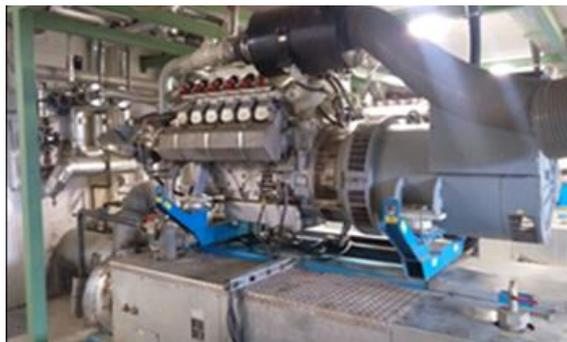
*Рис 2. Биогенератор производит 150 кВт в час электроэнергии.*
