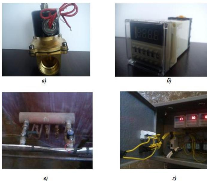
Рис. 1: а) электромагнитный клапан 2W-250-25; б) временное реле DH48S-S; в) электромагнитный клапан, врезанный в реактор для перемешивания сырья; г) подключение временных реле к сети и электромагнитному клапану.
